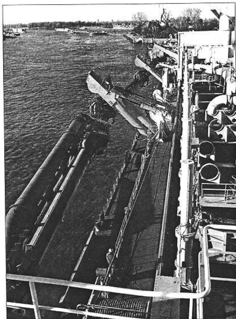
Fig. 3. Gezicht naar achteren aan dek (SB), met de lange zuigbuis in de bokken hangend (foto: IHC).
